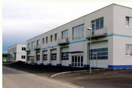
Stredisko správy a údržby Karbantartó és szolgáltató központ Management and maintenance center
